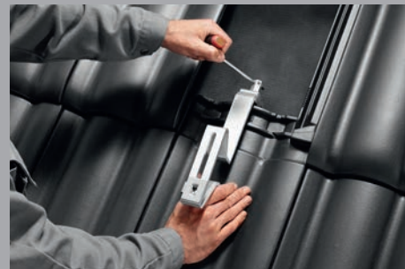
Crochet réglable pour le montage surtoits inclinés.
