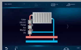
Surveillance / commande manuelle de circuit de chauffage
