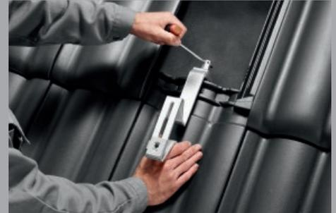
Verstellbarer Dachhaken für die Aufdachmontage.
